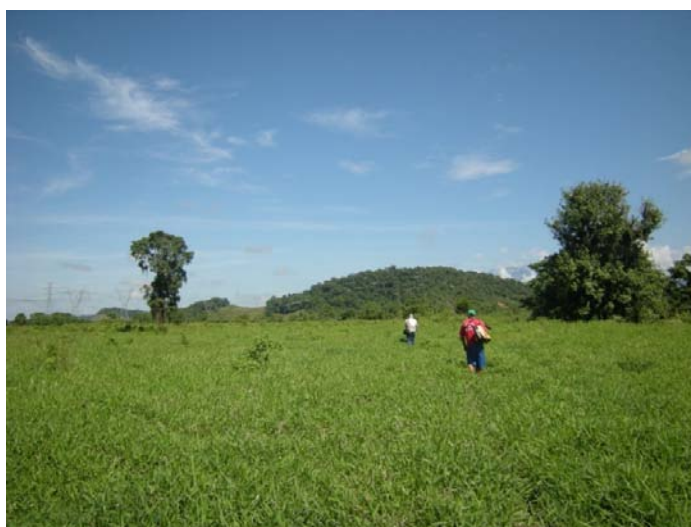
Figura 5.1.8 - Planície colúvio-aluvionar no local do eixo da barragem. Ao fundo, colina isolada sustentada por gnaisses da unidade Rio Negro onde será apoiada a ombreira direita da barragem (UTM: 722433/7503803)
