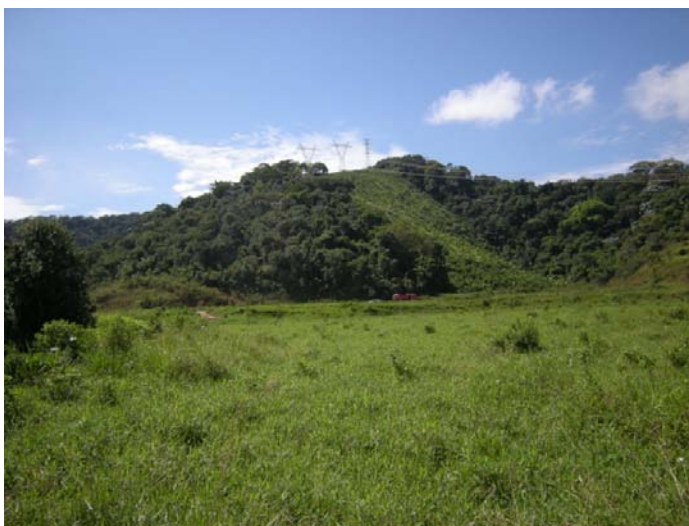
Figura 5.1.9 - Planície colúvio-aluvionar no local do eixo da barragem. Ao fundo, morro baixo sustentado por rochas gnáissicas da unidade São Fidelis - ombreira esquerda da barragem (UTM: 722433//7503803)
